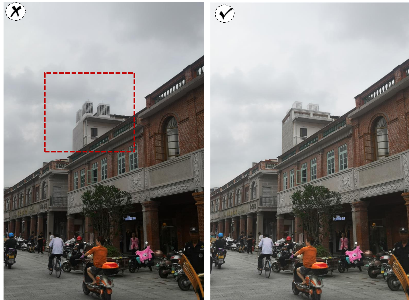
屋顶设施整治前后对比
